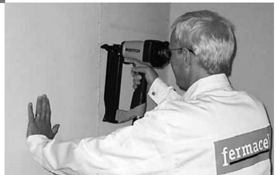
Einfache Anbringung an Decke und Dachschräge durch Klammern
