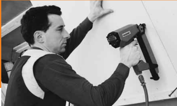
Klammern auf Holzunterkonstruktionen
