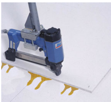
Bild 5: Verbindung der beiden FERMACELL Lagen mit Klammern.
