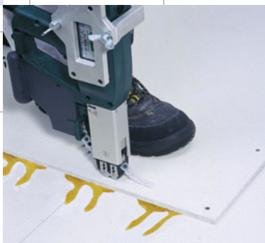
Bild 6: Verbindung der beiden FERMACELL Lagen mit Schrauben.
