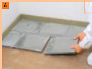
6 Powerpanel SE werden im schlep-penden Verband verlegt, so dass praktisch kein Verschnitt entsteht
