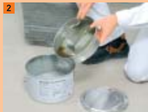
2 Die beiden Komponenten des Klebers werden zusammengebracht...
