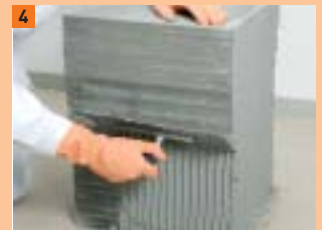
4 Der Kleber wird im Stapel nur auf die Plattenkanten aufgetragen
