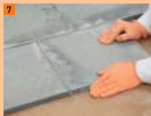
7 Die Platten werden dicht aneinander geschoben (Fugenbreite ca. 1–1,5 mm)
