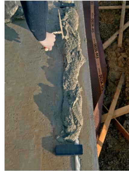
Untermörtelung mit FERMACELL Quellmörtel
