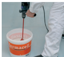
Mit geeignetem Rührgerät bei langsamer Drehzahl anmischen, bis eine homogene, klumpenfreie Spachtelmasse entsteht
