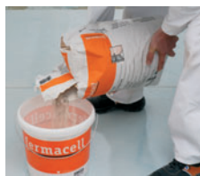
Im sauberen Gefäß anmischen; ca. 0,6 l Wasser/kg Gips-Flächenspachtel
