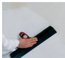
Großflächig auftragen und abschließend sauber abziehen
