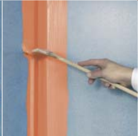
Abb. 2: FERMACELL Dichtband in die noch feuchte FERMACELL Flüssigfolie drücken und im 2. Arbeitsgang mit Flüssigfolie überstreichen
