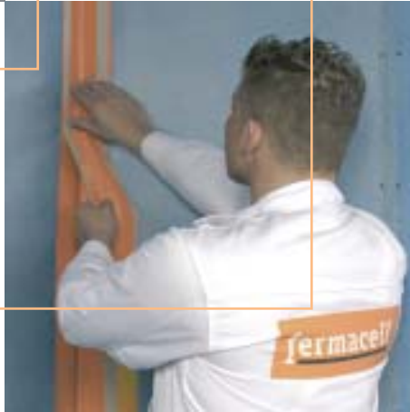
Abb. 2: FERMACELL Dichtband in die noch feuchte FERMACELL Flüssigfolie drücken und im 2. Arbeitsgang mit Flüssigfolie überstreichen
