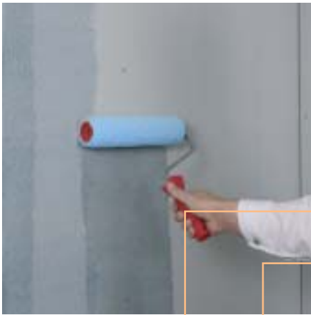
Abb. 1: Aufbringen des FERMACELL Voranstrichs
