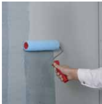
Abb. 1: Aufbringen des FERMACELL Tiefengrunds
