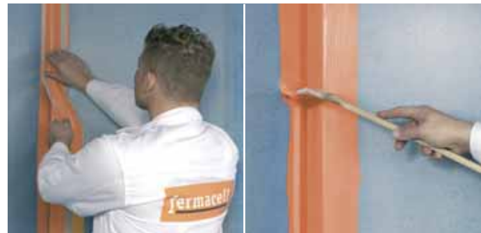
Abb. 2: FERMACELL Dichtband in die noch feuchte FERMACELL Flüssigfolie drücken und direkt mit Flüssigfolie überstreichen
