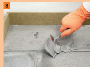
8 Überschüssiger Kleber wird mit einer Kelle aufgenommen und weiterverarbeitet
