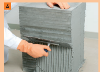
4 Der Kleber wird im Stapel nur auf die Plattenkanten aufgetragen
