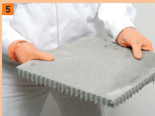
5 Mit einem 6 mm Zahnpachtel zieht man den Kleber an zwei Seiten des Plattenstapels auf
