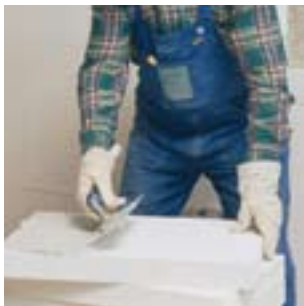
Les panneaux minéraux MULTIPOR se collent directement sur le mur à isoler.
